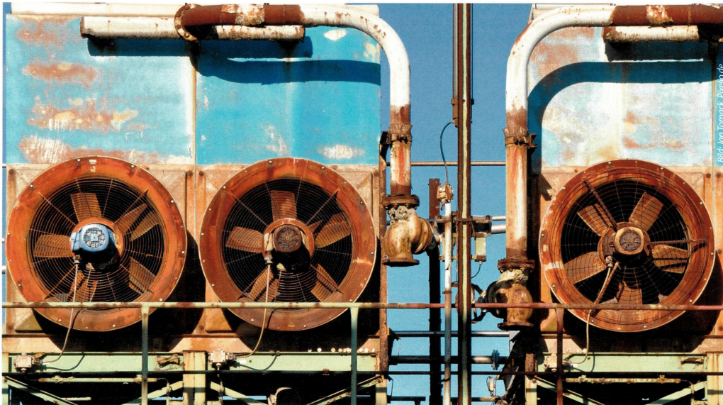
Stahlkonstruktionen werden durch zinkhaltige Grundierungen geschützt. Bis dato wird dabei der Zinkstaub hoch in der Primermatrix aufkonzentriert. Nun suchen Forscher nach Alternativen.
